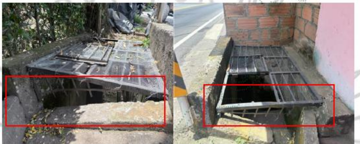
Imagen 4. Obra hidráulica transversales - Estado actual.
