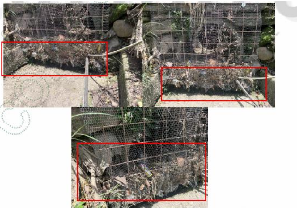
Imagen 5. Descole de las obras hidráulicas transversales.
