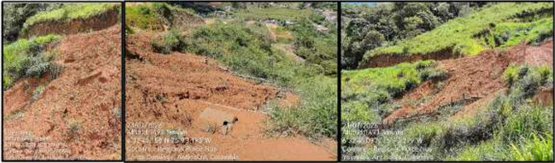
Imagen 4. Cornare. 2026. Trincho implementado para estabilización de talud descendente.
