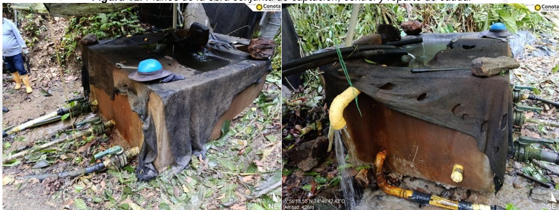
Figura 13 y 14. Obra conjunta de captación, control y reparto de caudal observada durante la visita
