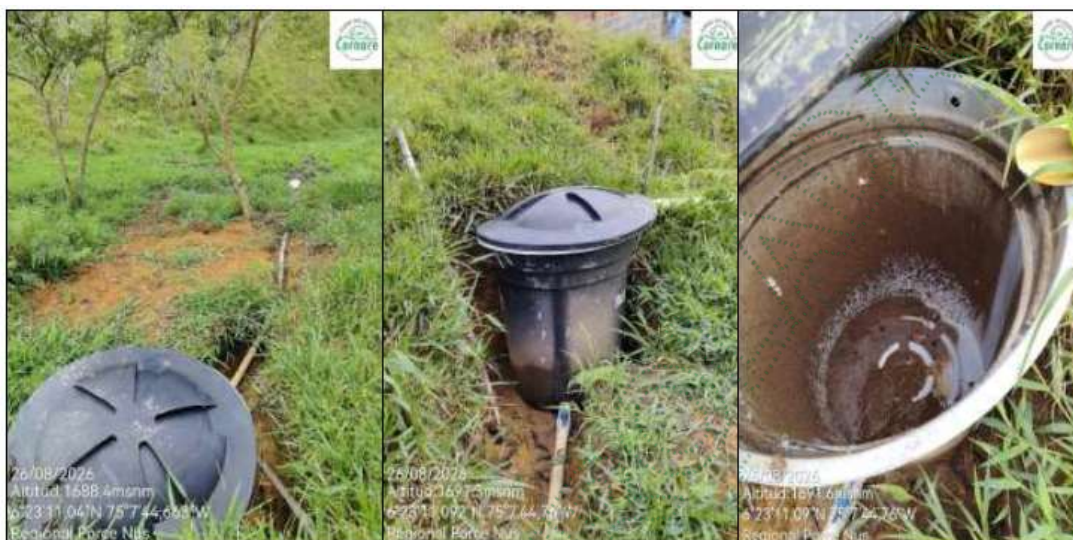
Imagen 4. Cornare. 2026. Estado actual del tanque estercolero.
