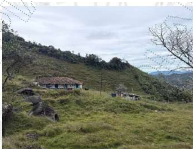
Imagen 2. Vivienda del Mayordomo.
