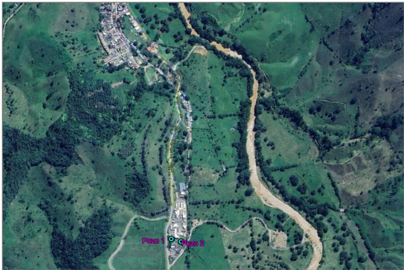
Figura 1. Localización de los Pozos 1 y 2 de la Planta de Frigorinus
