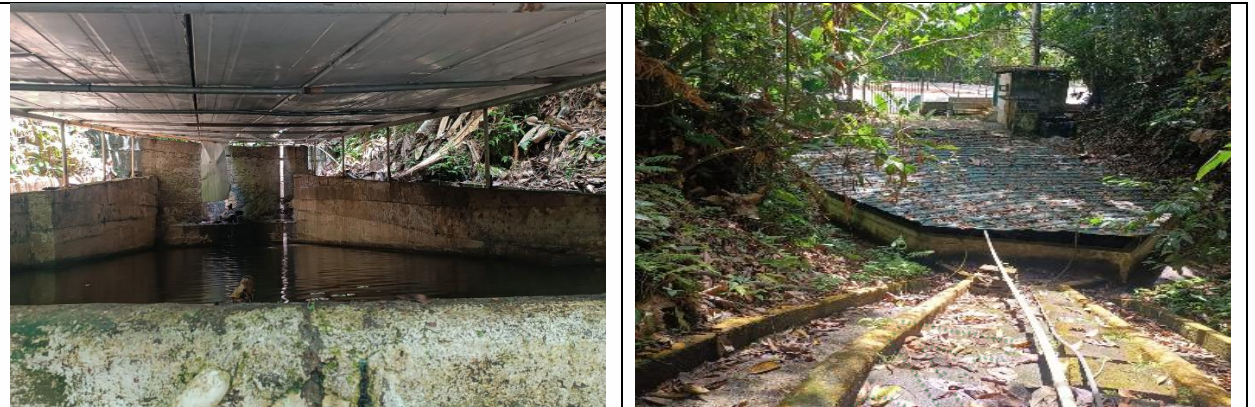
Imágenes 2 y 3. Captación del acueducto
