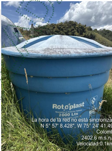
Tanque de almacenamiento 2000L
