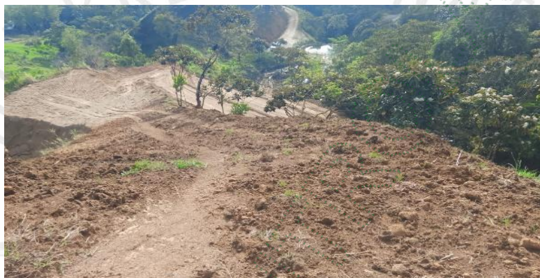
Imagen 2. Evidencia de la apertura de la vía y puntos de explanación.
