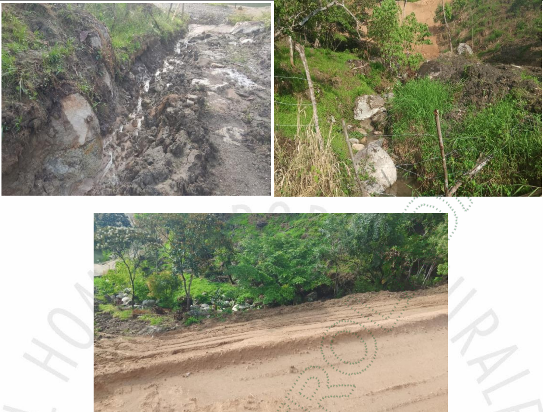
Imagen 4, 5, 6. Inicio de la apertura de vía e intervención directa a nacimiento de agua y franja de protección de la quebrada.
