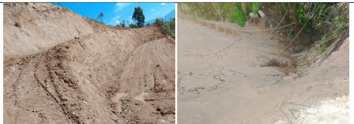
Imagen 7,8,9,10, Registros fotográficos de los movimientos de tierra y taludes
