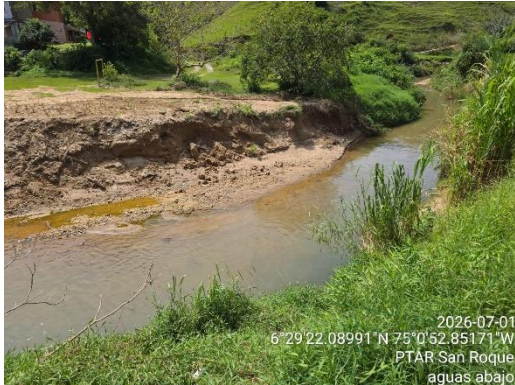
Fuente aguas abajo PTAR
