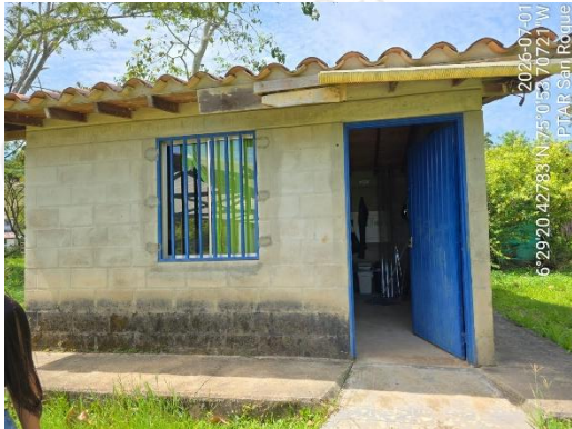
Caseta de operación
