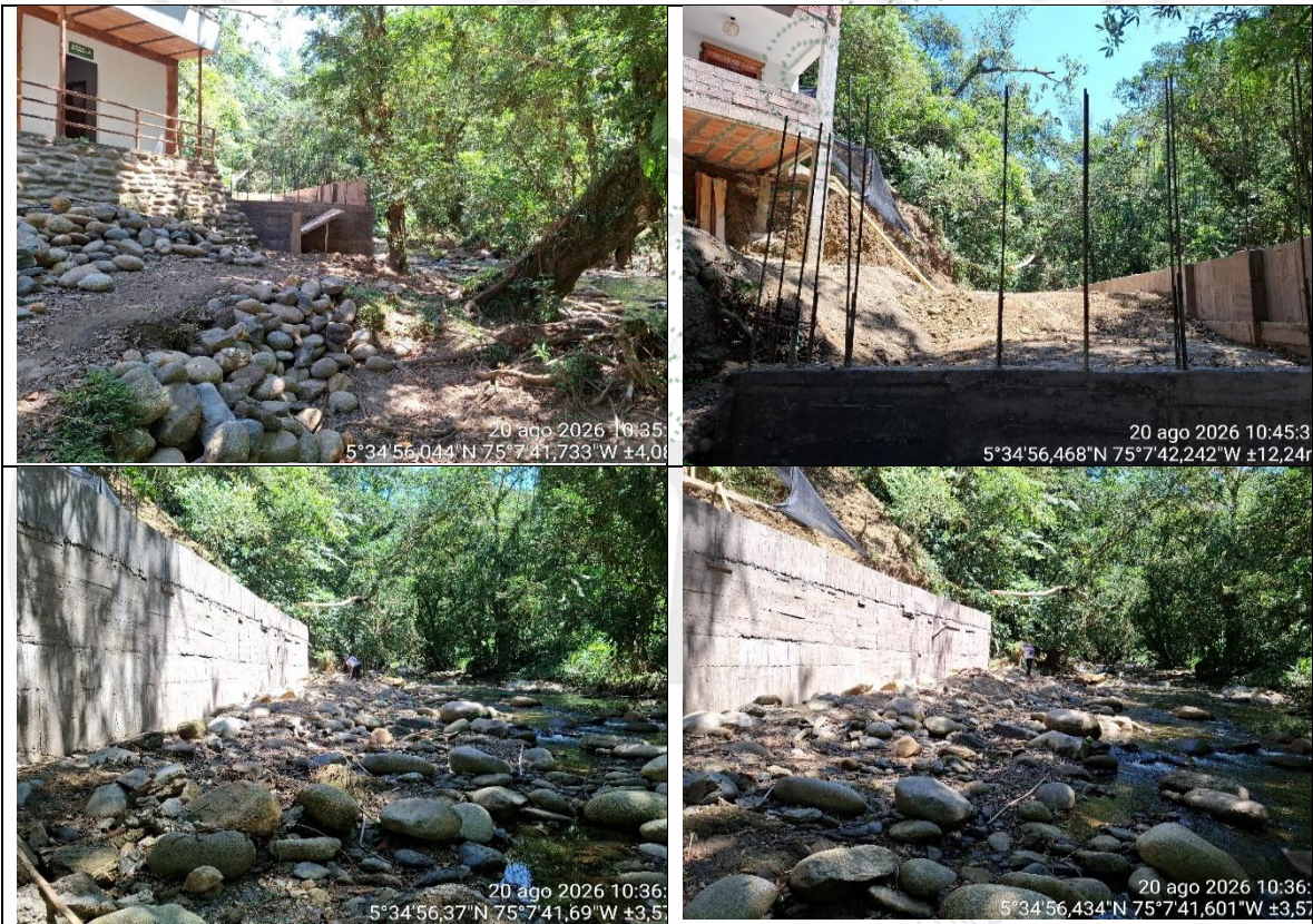
Obra N°1 en muro en concreto
