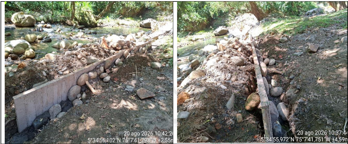
Obra N°2 en concreto ciclópeo.
