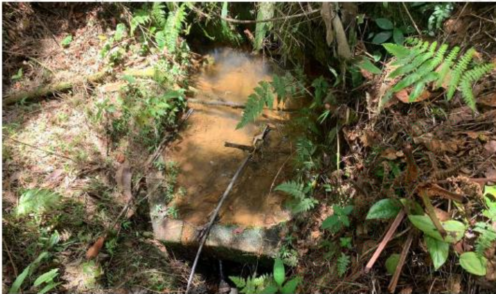
Figura 6. Obra de captación 2.
