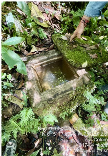
Cajas de registro
