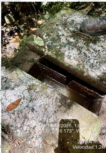
Desarenador, control de caudal
