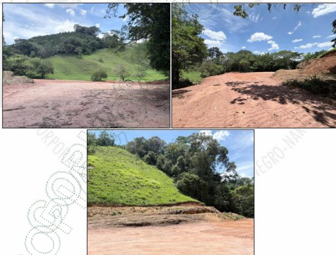
Imagen 1. Lote 3 - Nivelado y compactado.
