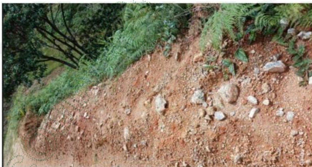
Imagen 10 tramo donde fue cambiada la tubería
