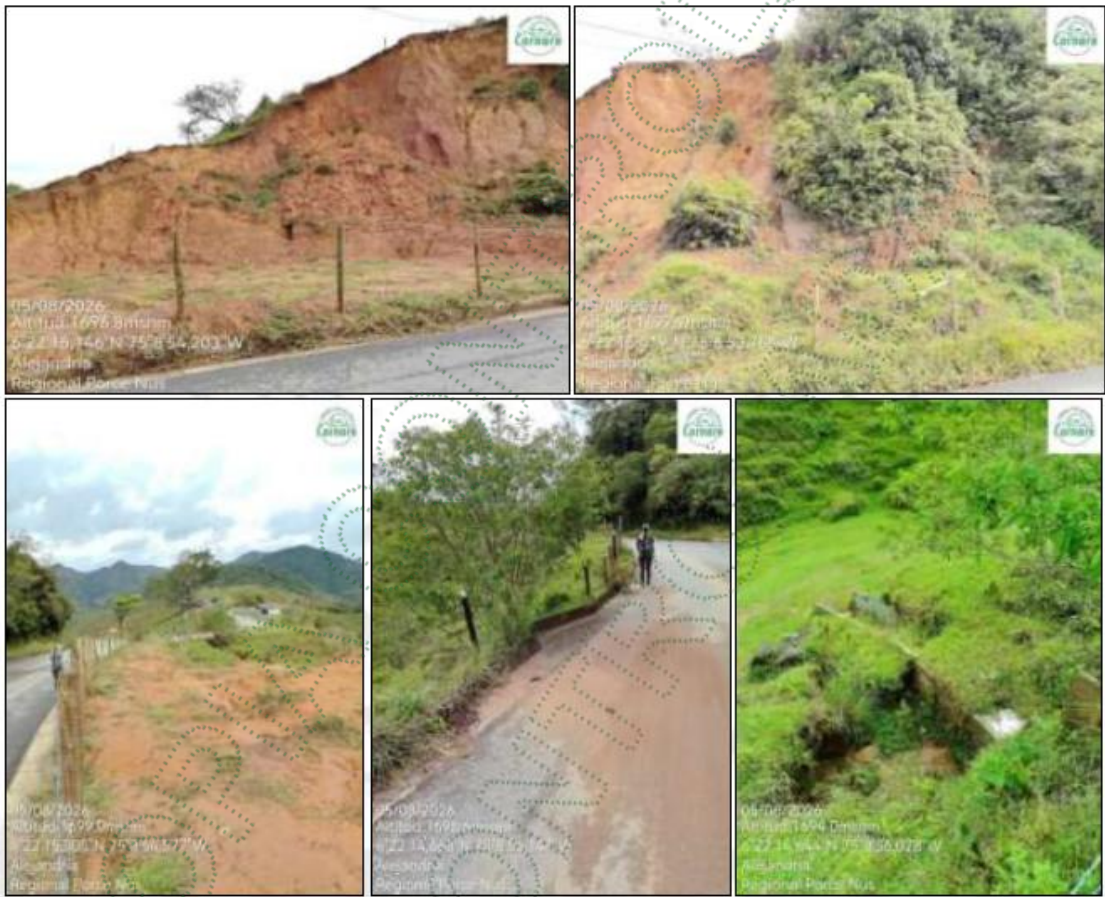
Imagen 1. Cornare. 2026. Estado actual del predio donde se realizaban actividades de extracción de material tipo Limo, para el relleno sanitario San Pedro, sin evidencias de labores recientes.
