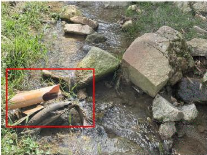
Imagen 4. Descarga puntual de Aguas residuales No domesticas - ARNDs
