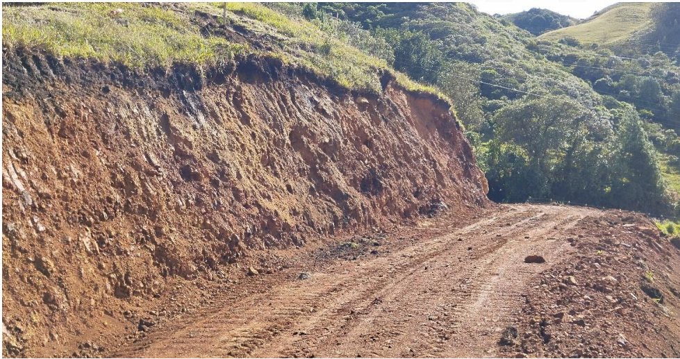
Taludes generados con más de 3 metros de altura
