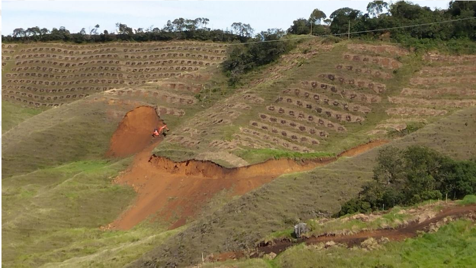
Apertura de vía con retroexcavadora encontrada en la visita operando
