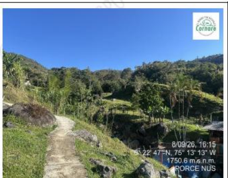
Imagen 3. Estado actual margen derecho de la vía.
