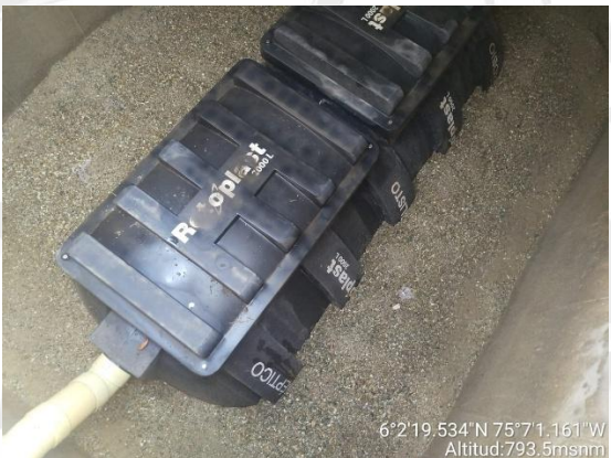
Imagen 5 y 6. Sistema de tratamiento de aguas residuales domésticas implementado en campo
