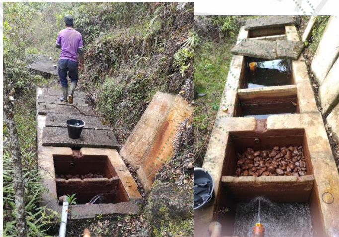
Imagen 2 y 3. Desarenador. Cornare 2026.
