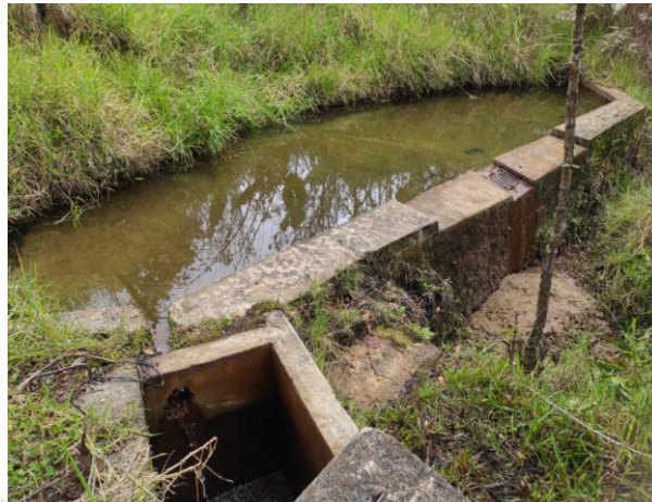
Imagen 1. Obra de captación Los Martínez. Cornare 2026.
