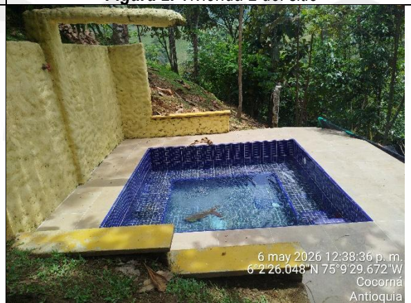
Figura 4. Piscina 2 en la parte baja del sitio
