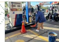
Fotografía 8. Se emplea aserrín como material absorbente
