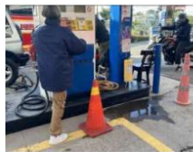
Fotografía 6. Tercero: se verifica que no haya más fuga o derrame y se delimita el área afectada
