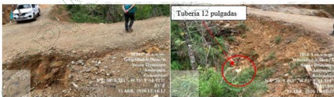
Figura 8. Ocupación de cauce fuente 2
