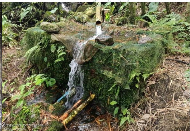
Imagen4. Tanque desarenador. Cornare 2026
