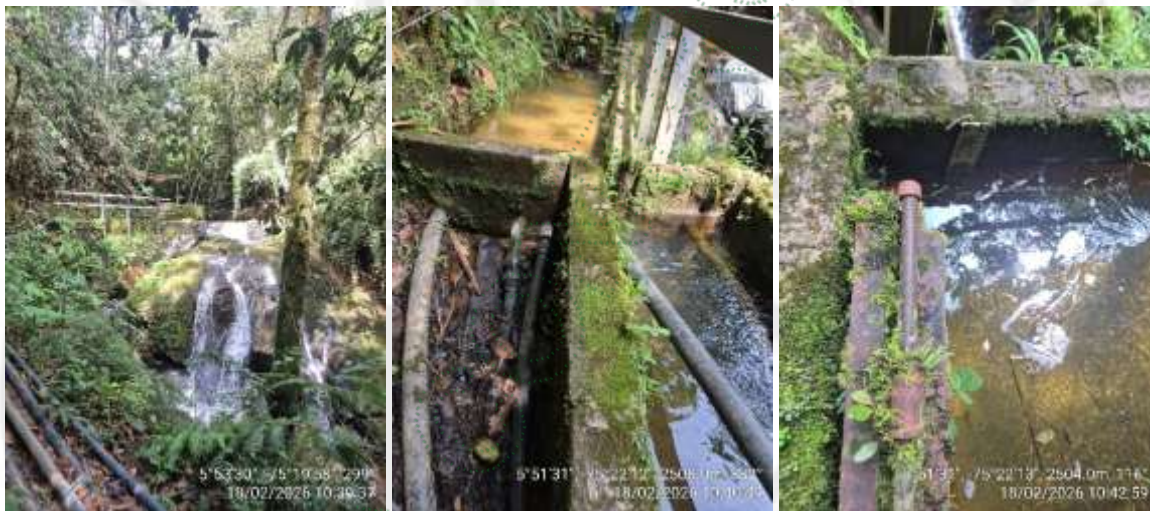
Imagen 2. Izquierda: punto de captación de la fuente hídrica Quebrada Negra. Centro: desarenadores. Derecha: regla limnimétrica calibrada.
