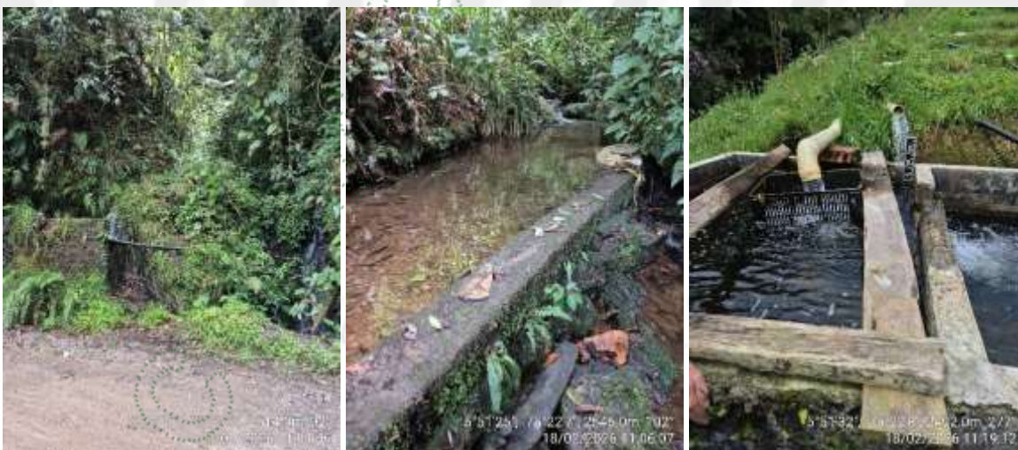
Imagen 4. Izquierda y centro: punto de captación de la fuente hídrica Quebrada Negra. Derecha: desarenadores y regla limnimétrica calibrada.
