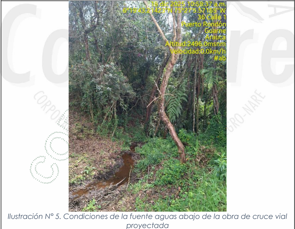
Ilustración N° 5. Condiciones de la fuente aguas abajo de la obra de cruce vial proyectada
