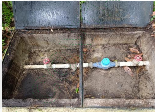
Instalación del sistema de medición
