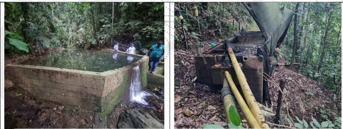
Foto 1 y 2. Punto de captación y tanque desarenador de la fuente “Dosquebradas”.
