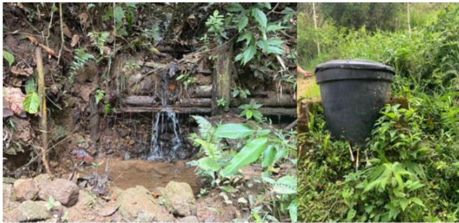
Figura 2. Fuente abastecedora y tanque de almacenamiento
