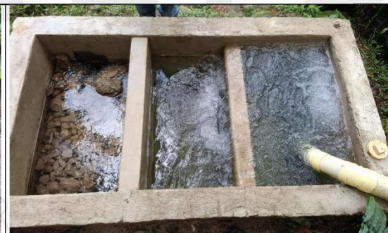
Imagen2. Tanque desarenador. Cornare 2026
