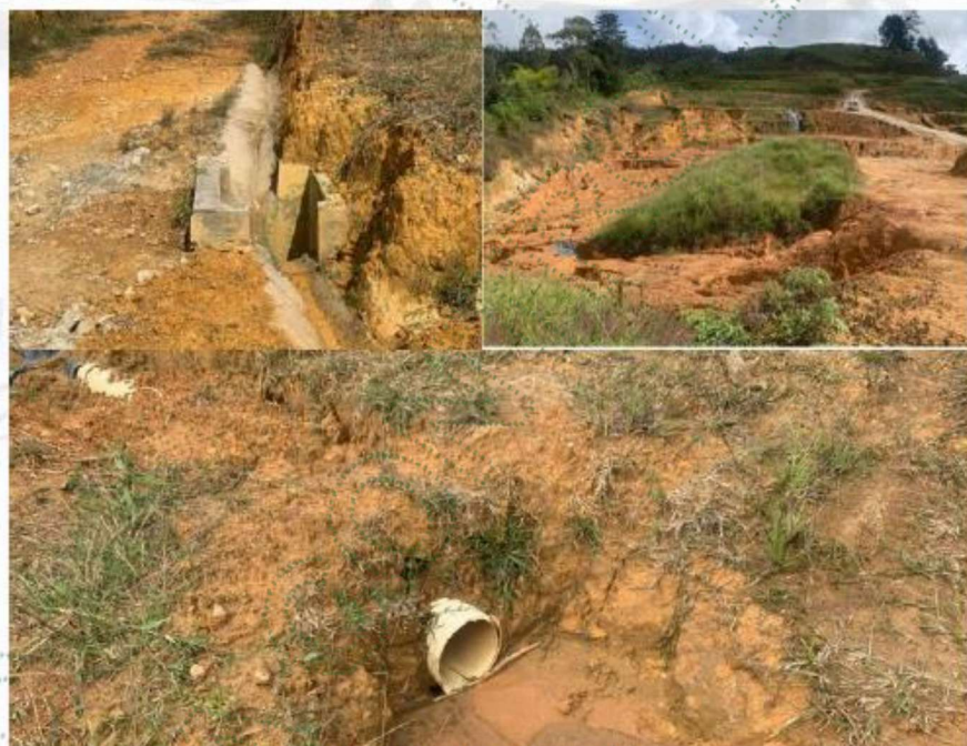
Figura1. Obras de mitigación
