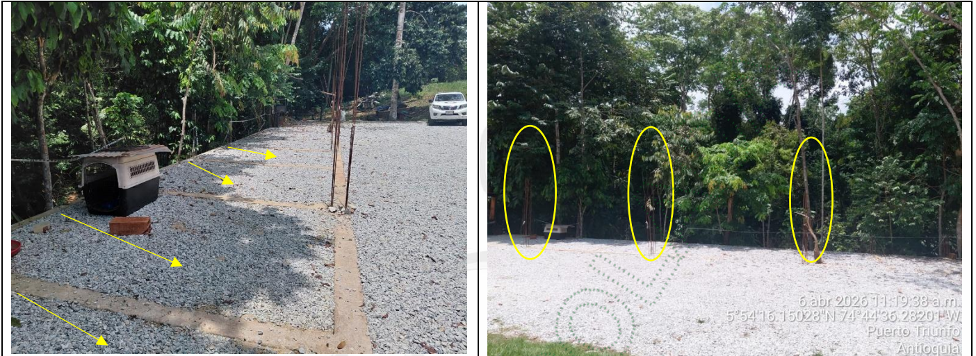
Localización de cimentación para futura construcción de habitaciones
