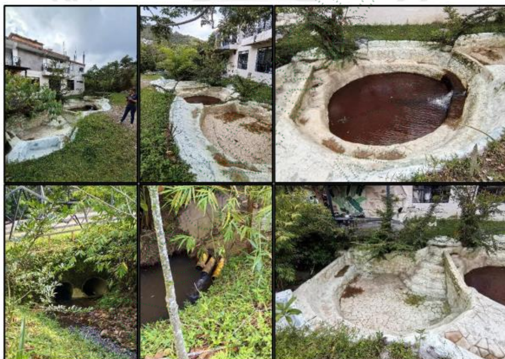
Imagen 1. Cornare. 2026. Estado de la obra de las piscinas construidas por la señora Lorena Zuluaga.
