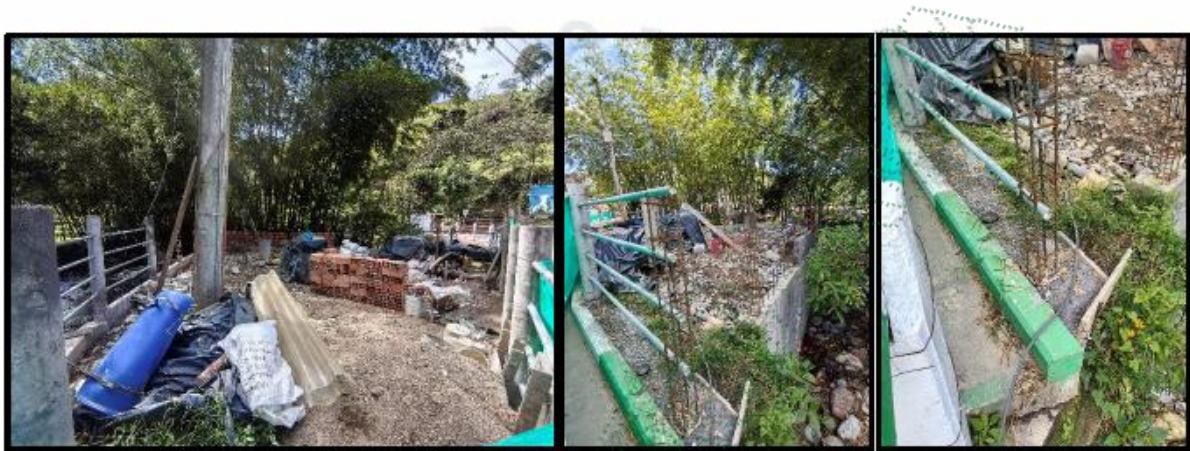
Imagen 2. Cornare. 2026. Estado del corral del señor Carlos Franco en proceso de construcción.
