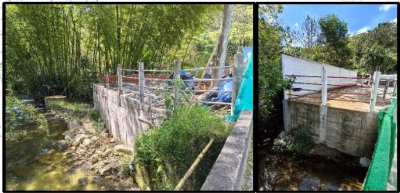
Imagen 3. Cornare. 2026. Muros de contención levantados para la nivelación del terreno y construcción de los corrales.
