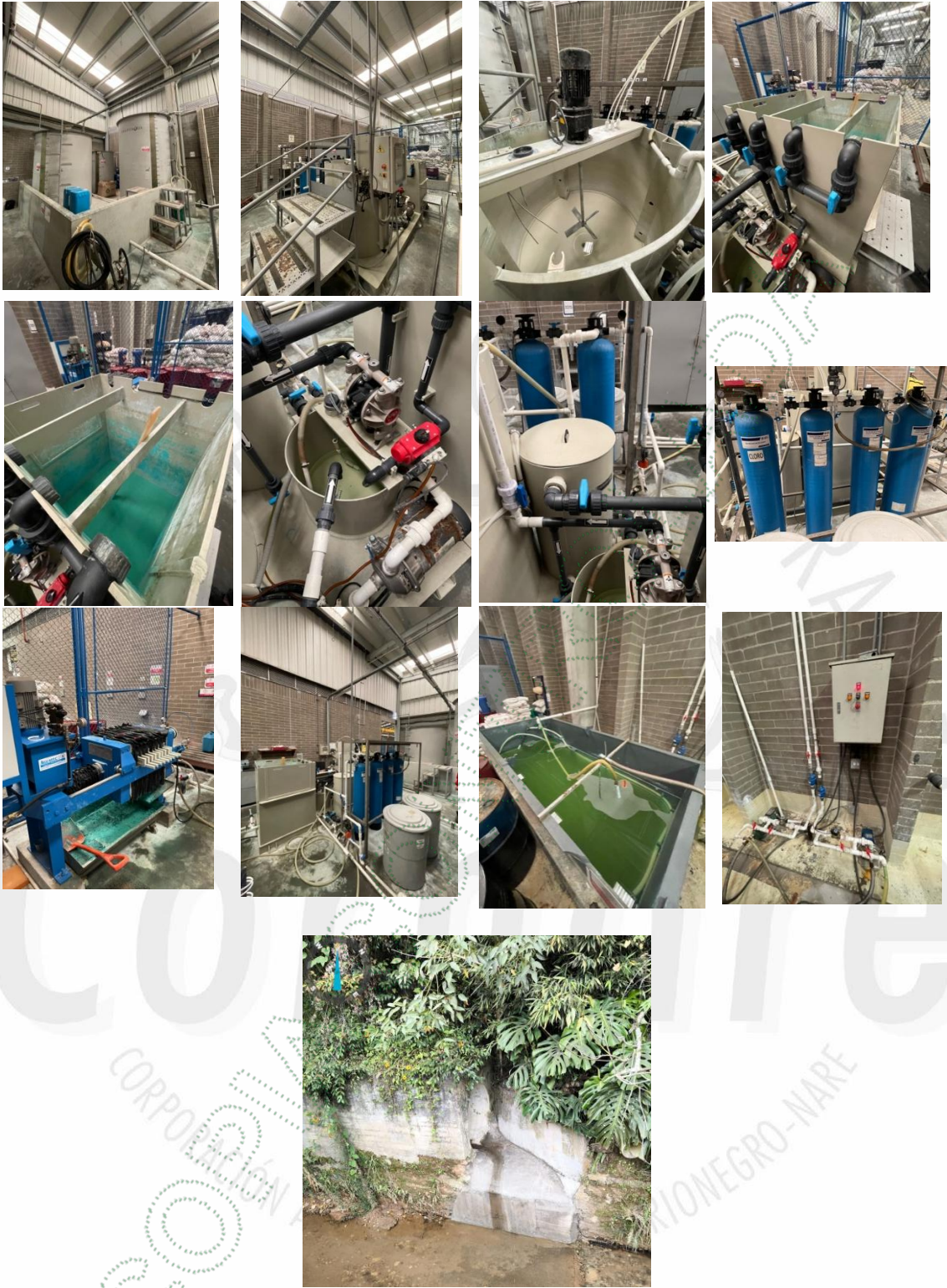
Estructura de descarga del vertimiento en la fuente receptora.
