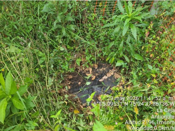
Fotografía 1. STARD fase constructiva
