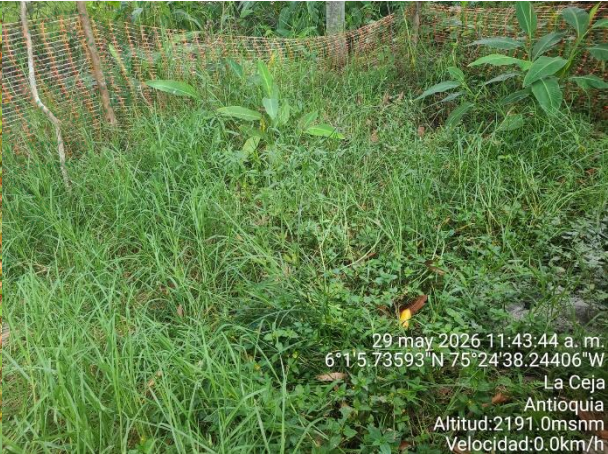
Fotografía 2. Campo de infiltración STARD fase constructiva
