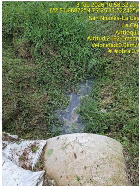
Ilustración N° 5. Localización de la Obra N°3 existente en sitio actualmente – Aguas arriba
