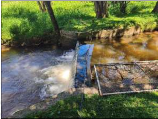
Figura 8. Punto para la captación de la fuente “La Enea”
