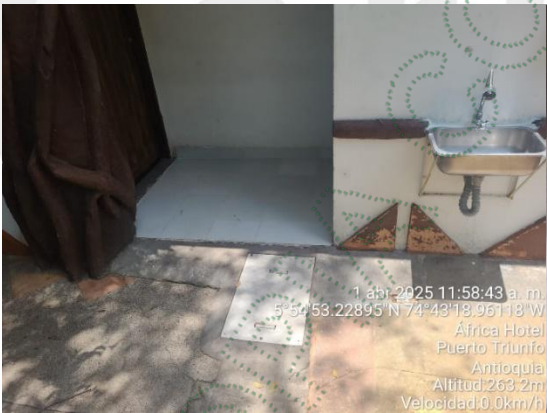
Fotografía 3. trampa de grasas, observado en campo
