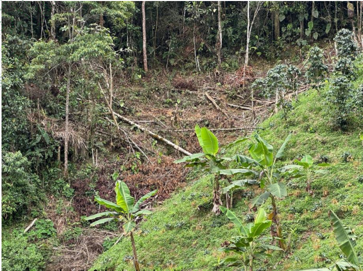
Imagen 6. Árboles talados y lote en rocería.
