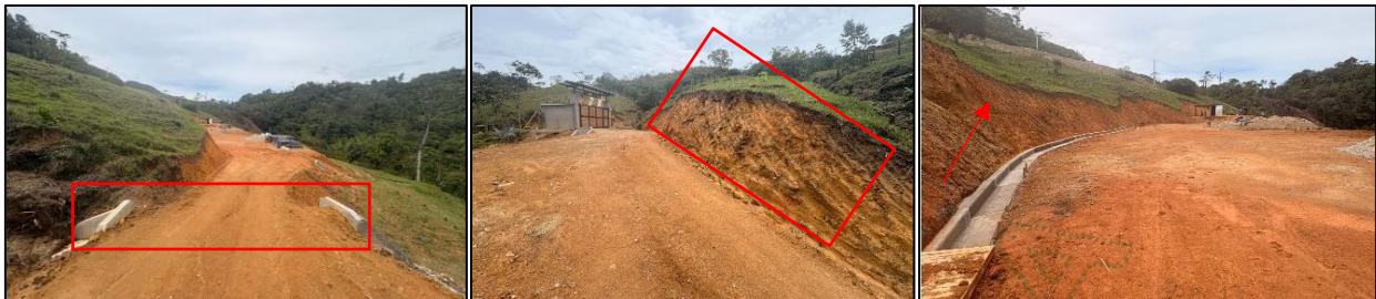
Imagen 1. Nivelación y compactación de suelo y sistema de drenajes
