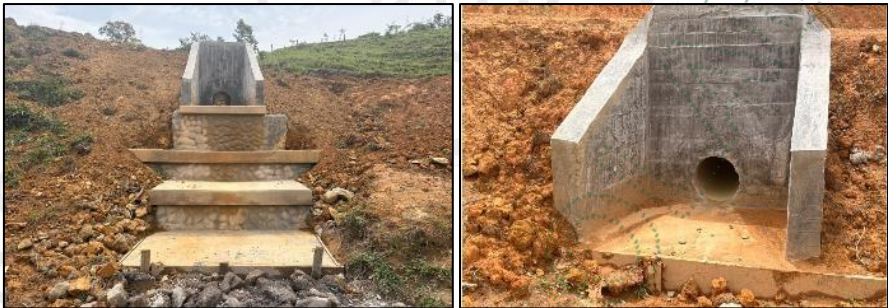
Imagen 2. Obras Transversales –(Drenaje).
