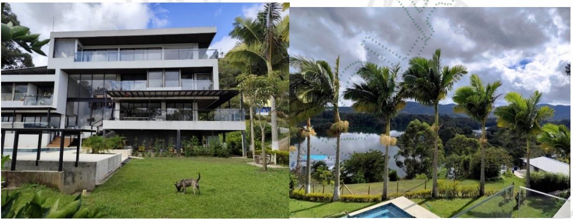
Foto N° 1 Finalización de obras de construcción hotel
