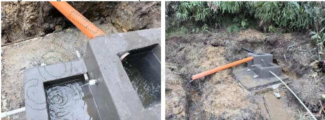
Imágenes 1 y 2. Obra de captación. tomado de CE-21671-2025.
