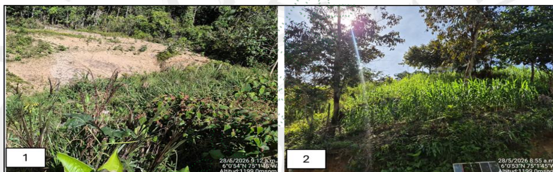
Imagen 1 y 2: Pasto vetiver en los taludes previamente expuestos. Fuente Cornare , 2026.
