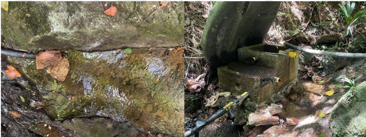
Figura 4. Captación y obra de control de caudal. Fuente: Cornare 2026
