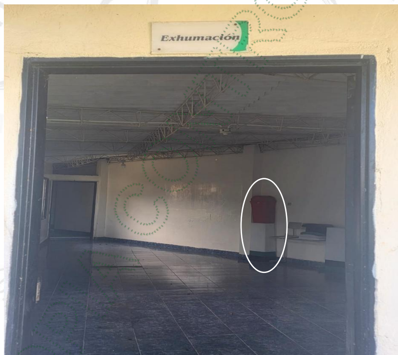
Punto ecológico en pasillo y en el cuarto de exhumaciones
