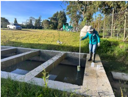
Imagen 1. Toma de muestra de agua en la entrada de la PTAR (estructura inundada)
