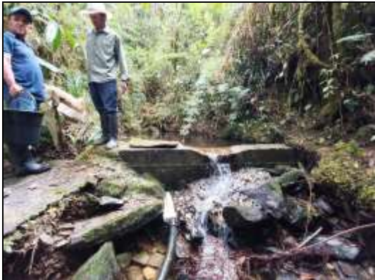
Figura 8. Punto para la captación de la fuente “San Juan”
