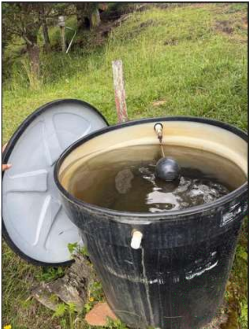
Tanque de Almacenamiento de 500 Lts.
